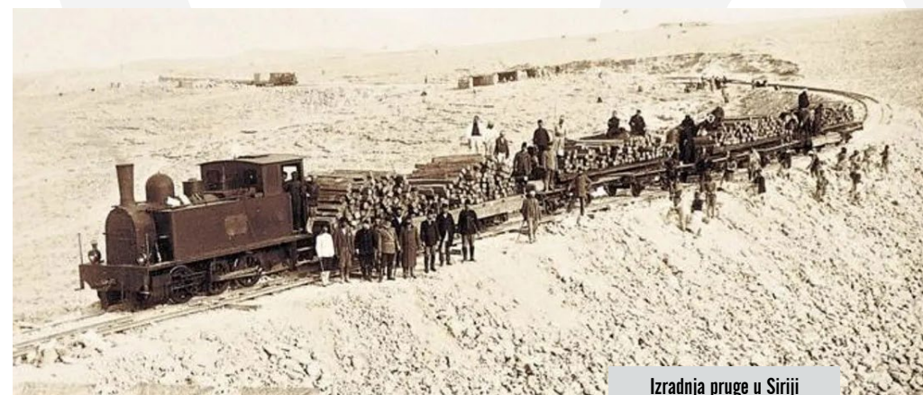
Izgradnja pruge u Siriji
